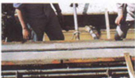
5. Una vez seco KUNISEAL queda perfectamente adherido al cemento
